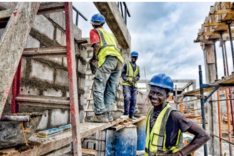
Derzeit errichten wir für das Krankenhaus eine Geburtsstation und eine Neonatologie.
